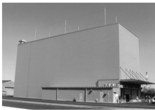
屋内貯蔵所303施設
