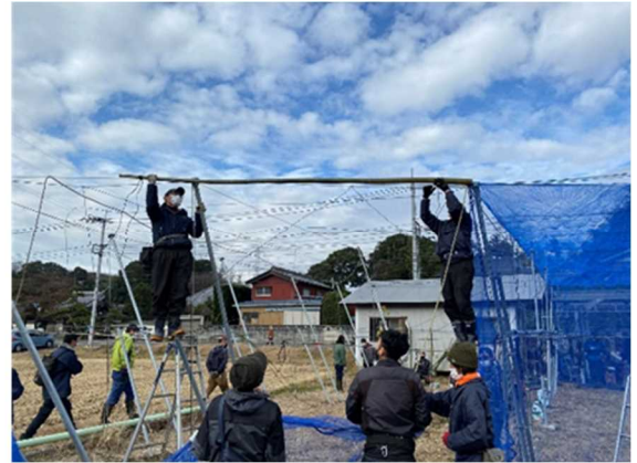
エ 網を引き上げるときに鋼線に 引っかからないよう、竹の支柱 などを取り付ける。
