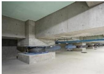
図：免震装置設置状況
