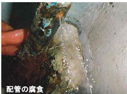
配管の腐食
