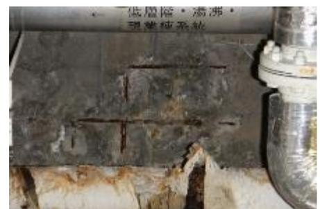
図：コンクリートの爆裂や剥落
