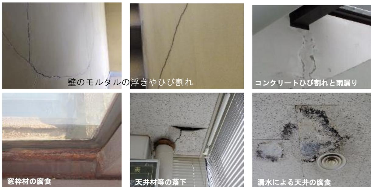
図：構造体以外の建物部分（仕上げ）の老朽化
