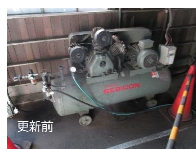
コンプレッサー更新
