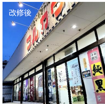
照明設備のLED化、空調の更新
