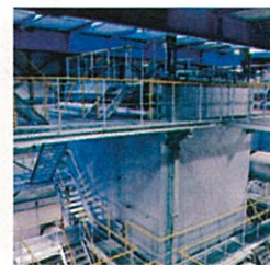
5 バグフィルタ Bag filter 燃焼ガス中のばいじんを、内部に設置されたろ過用の布によって捕集することにより、ダイオキシン類、重金属、塩化水素等の有害物質を除去します。
