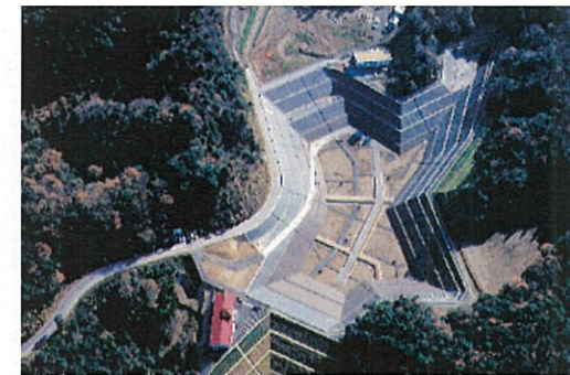
■B2 地区埋立処分場
