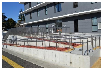
第1庁舎（防災庁舎）の バリアフリー
