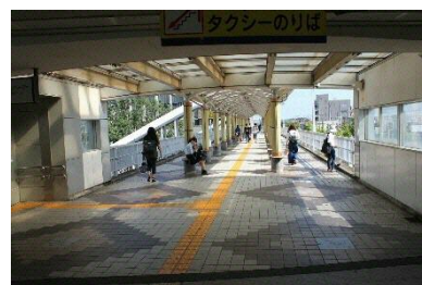
五井駅東口自由通路
