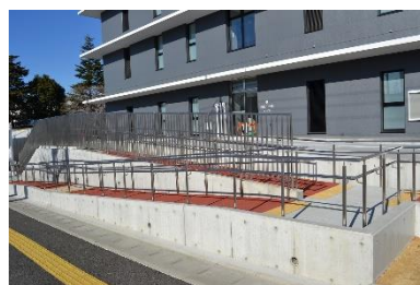
第1庁舎（防災庁舎）の バリアフリー
